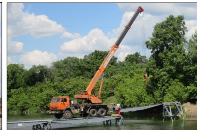
Переустановка КМК автокраном, вывешенным на сближенных опорах
