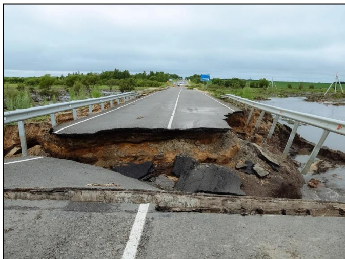
02.08.2021 Бурейский район Амурской области. Мост через реку Кулустай
