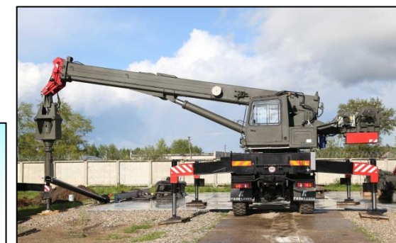
Завинчивание (вывинчивание) винтовых свай
