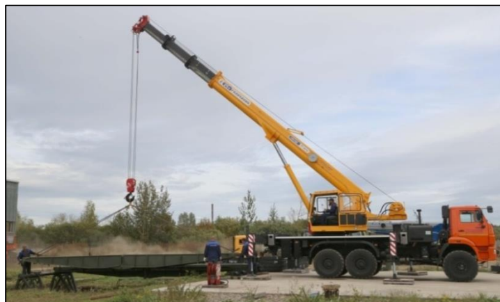
Установка пролетного строения
