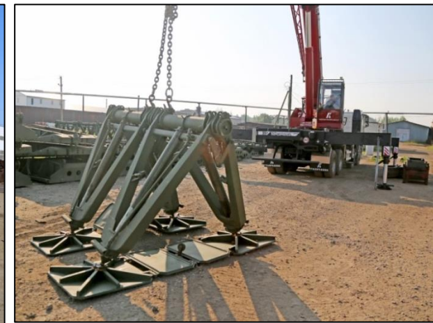
Разгрузка и установка промежуточных опор
