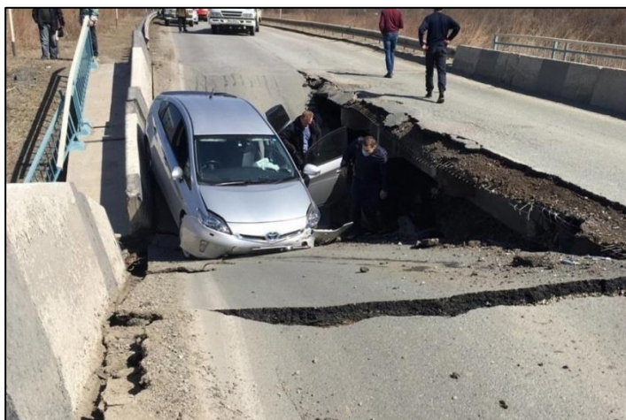
03.04.2020 Мост в районе села Романовка Шкотовского района Приморского края. Река Суходол
