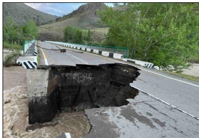
13.06.2023 Барун-Хемчикский район Республика Тыва. Мост на реке Ак
