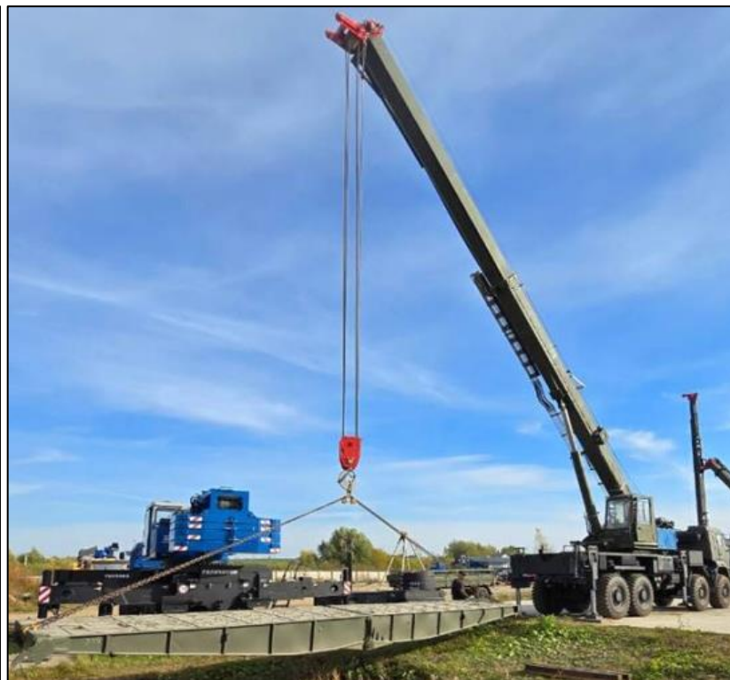
Установка секции пролетного строения на препятствие
