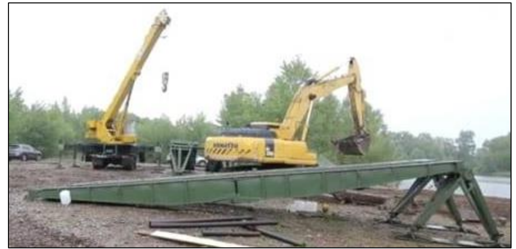
Подготовка секции КМК к установке
