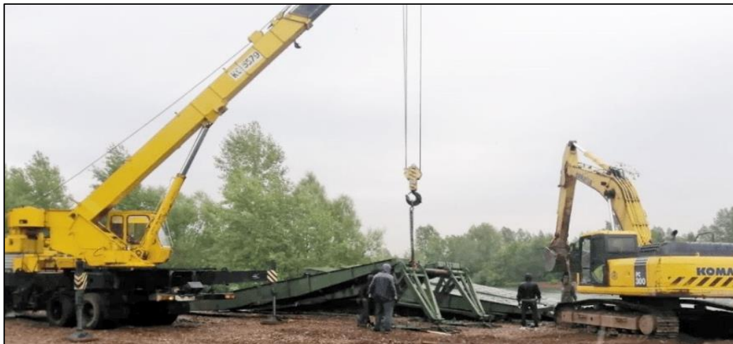
Подготовка секции КМК к установке
