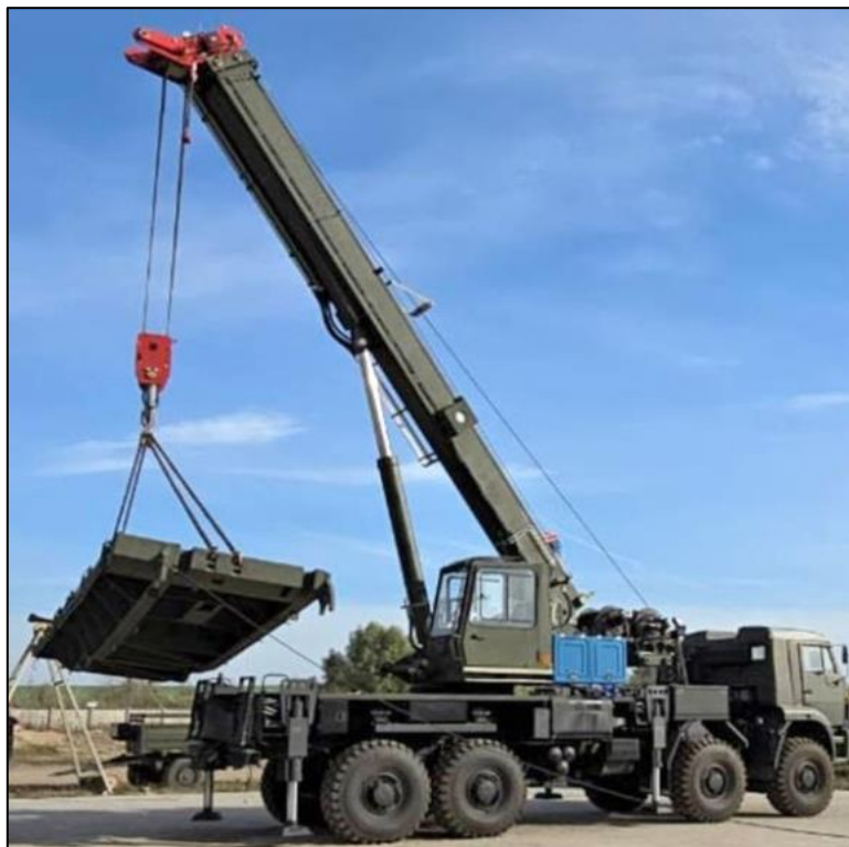
Передвижение с секцией пролетного строения Штоки гидроцилиндров опор подняты
