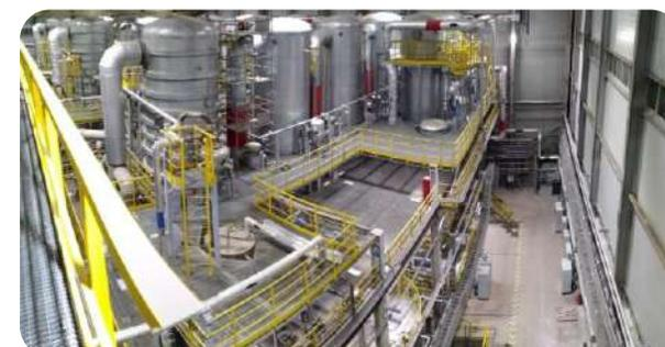
Выпарные установки водоподготовки, опреснения и очистки соледержащих стоков
