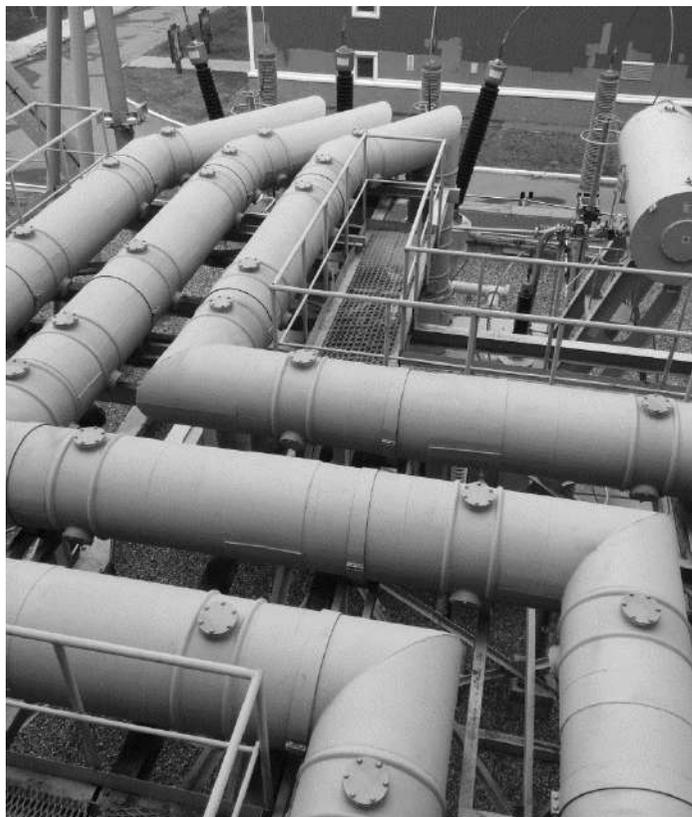
Токопроводы пофазно-экранированные с воздушной изоляцией (ТПЭВИ) генераторного напряжения специально разработаны для выполнения электротехнических соединений в цепях турбогенератор – генераторный выключатель – блочный повышающий трансформатор – трансформаторы собственных нужд – распределительные устройства собственных нужд.
