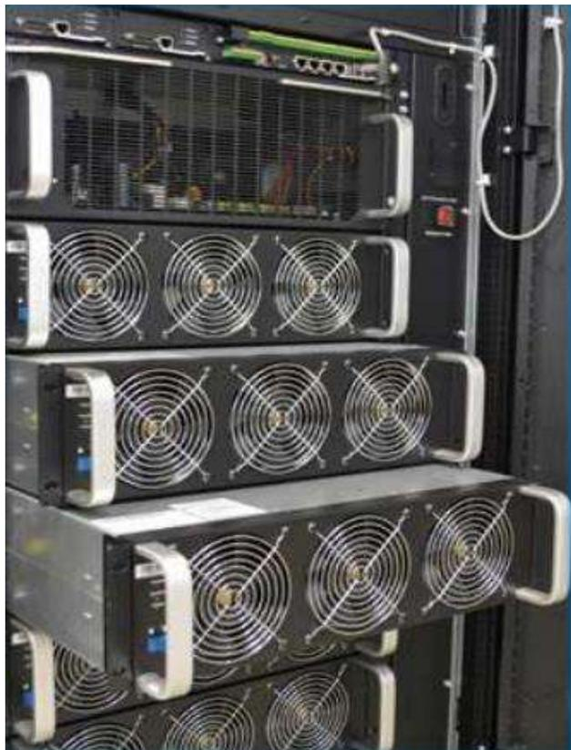
ИБП обеспечивают высокое качество выходного напряжения, защиту от проблем в электросети и длительное автономное функционирование защищаемой нагрузки.
